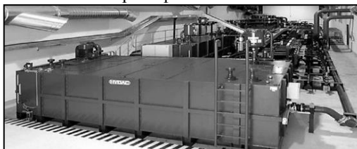
Рис.2 – Компоновка МНС фирмы HYDAC
