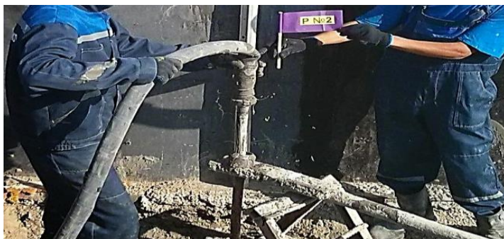
Рисунок 1 - Нагнетание уплотняющего раствора в грунт
