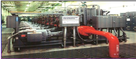
Рис.3 – Компоновка МНС фирмы Mannesmann Rexroth
