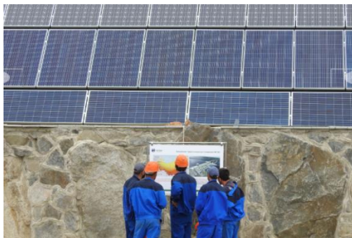
Рисунок 1 – СЭС на Нижне-Бурейской ГЭС
