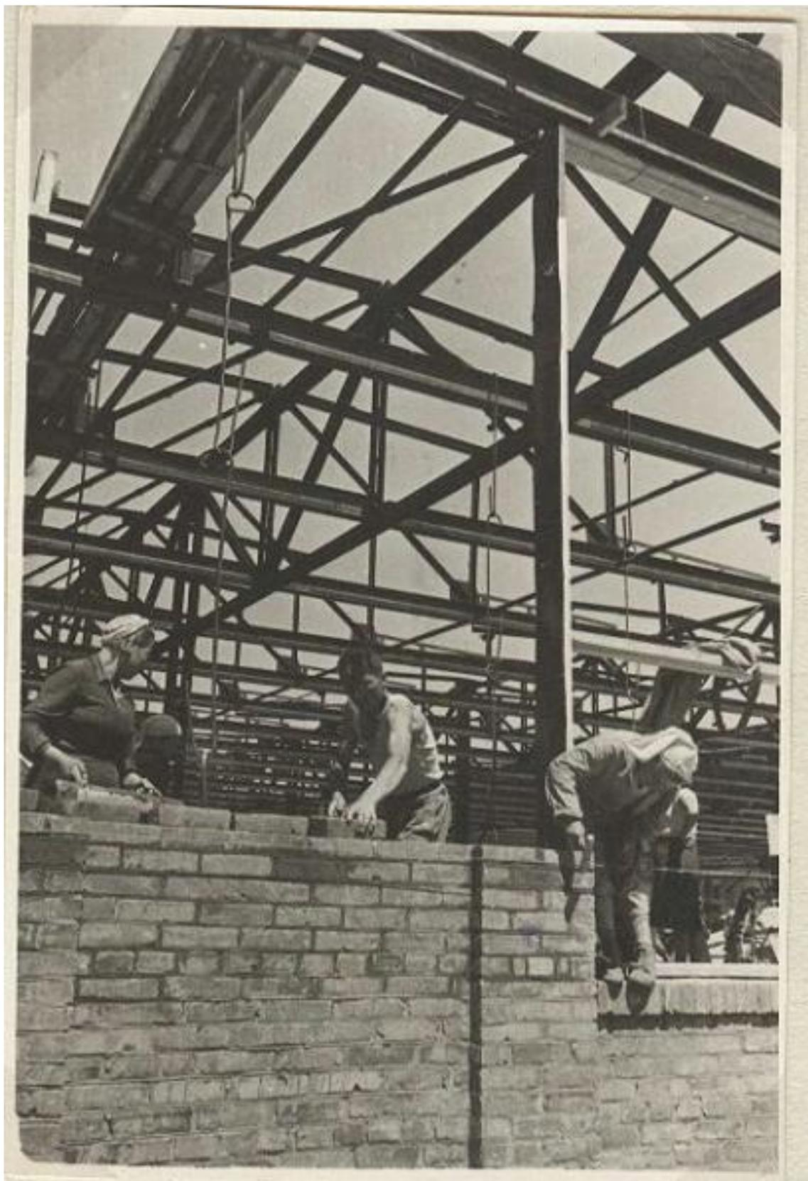
Рис. 2. Рис. 2. Восстановление конвейерного цеха тракторного завода в Сталинграде, 1944 г.
