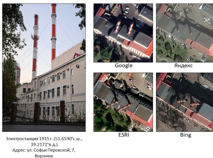
Рис. : 1. Вид стационарного источника выбросов с земли и на фрагментах космических снимков на примере котельной Электростанции 1915 года, город Воронеж
